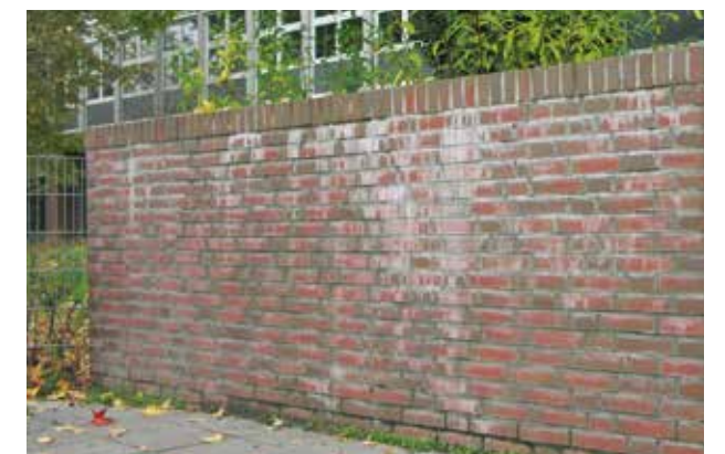
So bitte nicht: Die Oberkante dieser Mauer wurde manuell erstellt. Die Folge: Regenwasser dringt ins Mauerwerk ein und verursacht hässliche Auslaugungen. Mit einer vorgefertigten Mauerwerksabdeckung von Röben wäre das nicht passiert.
