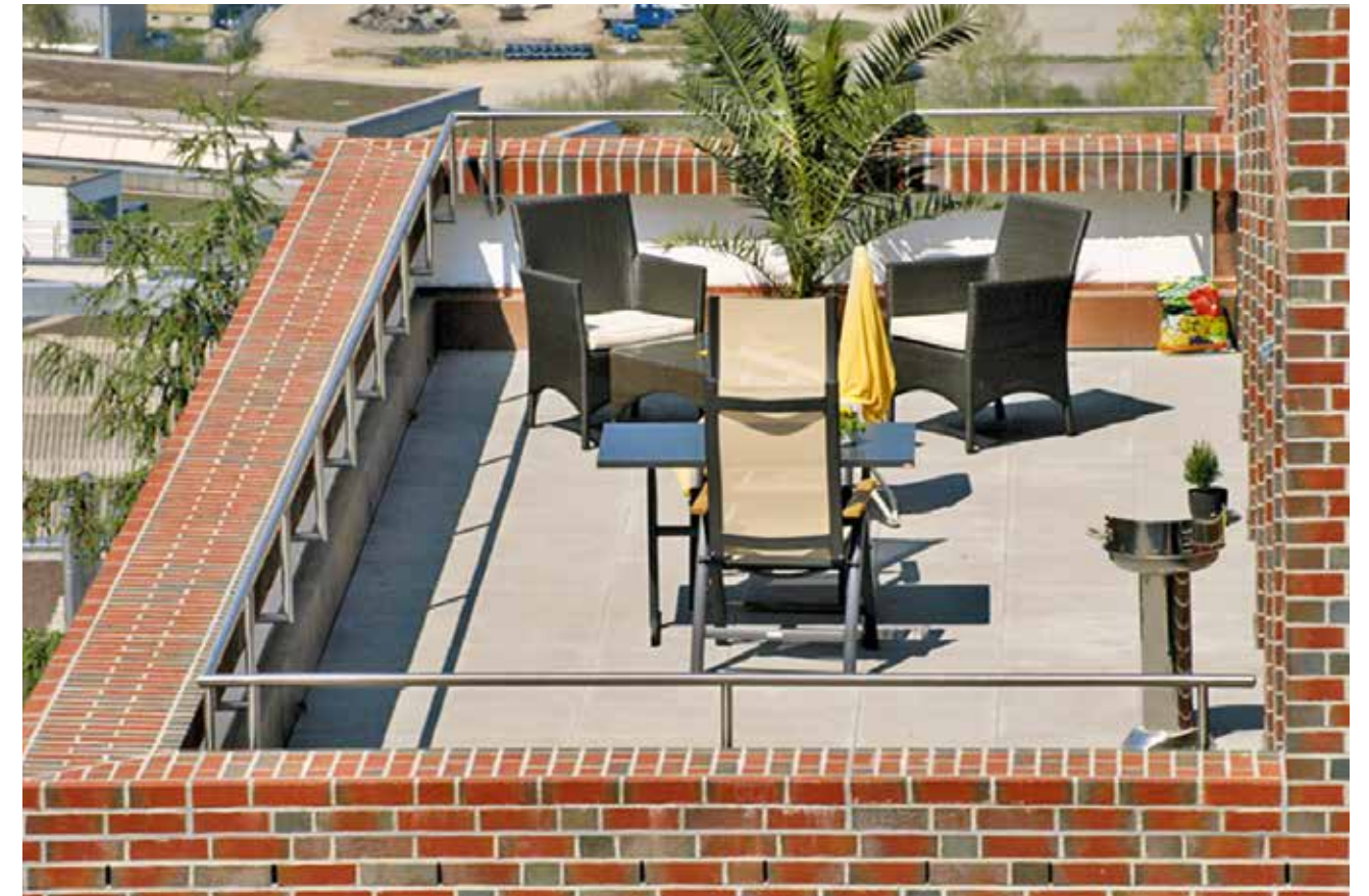
Die Brüstung dieser Dachterrasse wurde mit nach innen geneigten, schlagregendichten Fertigbauteilen abgedeckt.
