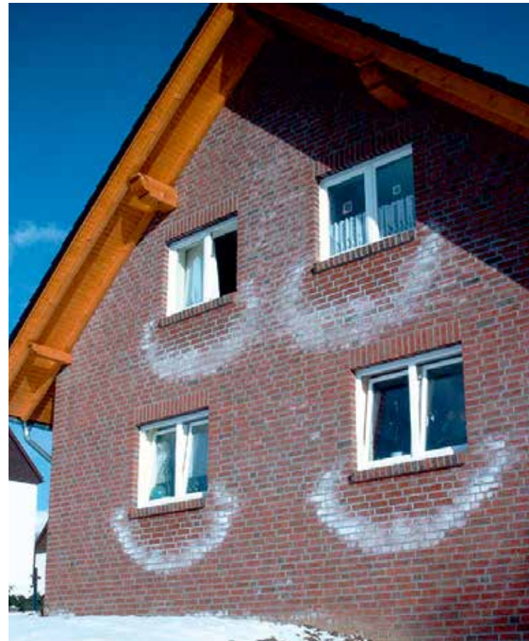
Ausblühungen (hier im Bild die sogenannten „Wassersäcke“), entstanden durch Regenwasser, das durch die konventionell gemauerten Fensterbänke in das Mauerwerk eingedrungen ist.
