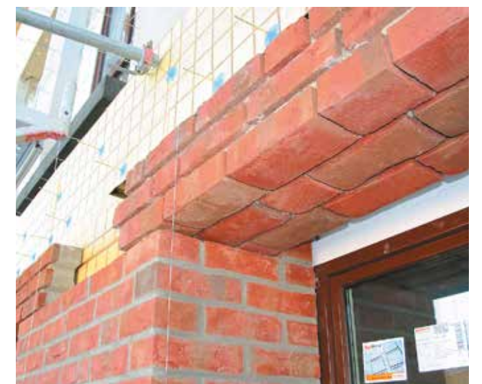
Läufersturz mit direktem Auflager, hier mit größerer Laibungstiefe.
